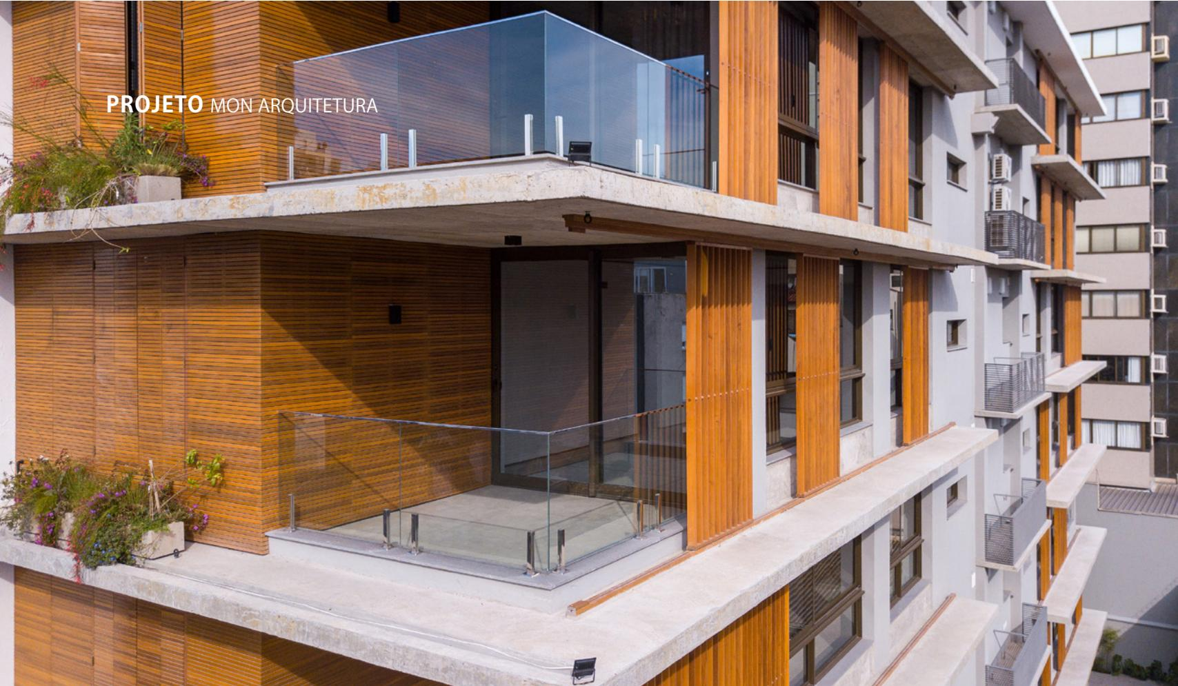
As sacadas possuem brises móveis para melhor aproveitamento da luz e melhoria do conforto térmico. Os vidros utilizados no prédio reduzem a entrada de calor e bloqueiam os raios ultravioleta.
