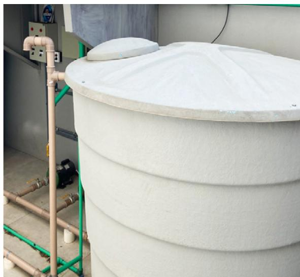
Cisternas armazenam a água da chuva e a gerada pela condensação dos aparelhos de ar-condicionado. Um aparelho pode produzir até 20 litros de água por dia, para aproveitamento na irrigação dos jardins.
