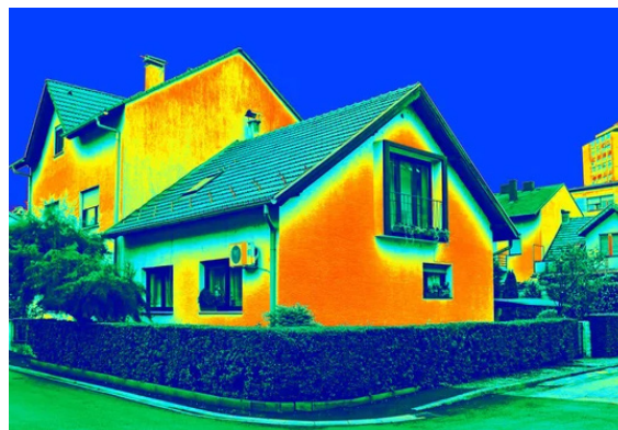
Uma câmera de imagem térmica pode visualizar áreas de perda ou ganho de calor, facilitando a identificação e o tratamento de pontes térmicas.
